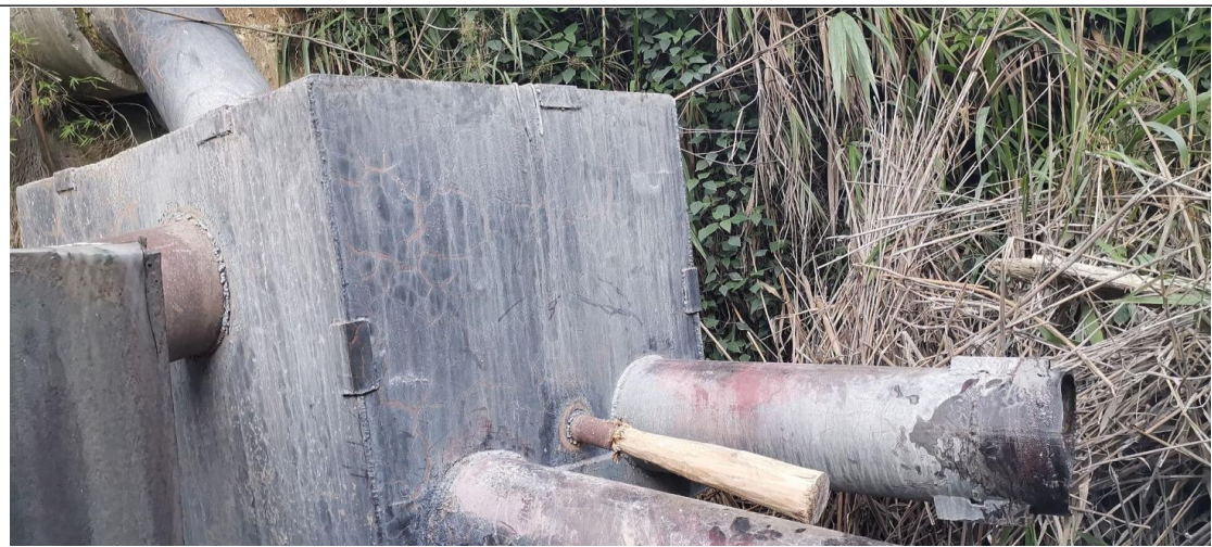
10月23日 回水池管道已拆除部分，正在转移回水设施至尾矿库内
